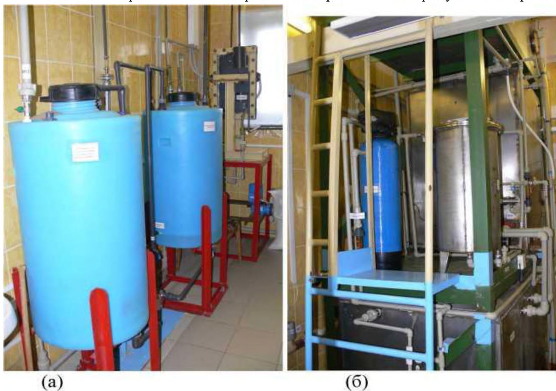
Рис. 3.5. Электрохимическая обработка оборотных вод: продукты электролиза
