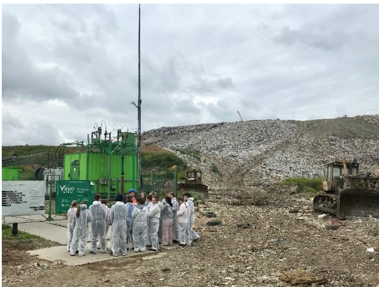
Рисунок 1. Полигон захоронения твёрдых коммунальных отходов г. Санкт-Петербурга «Новый Свет Эко», Гатчинский район
