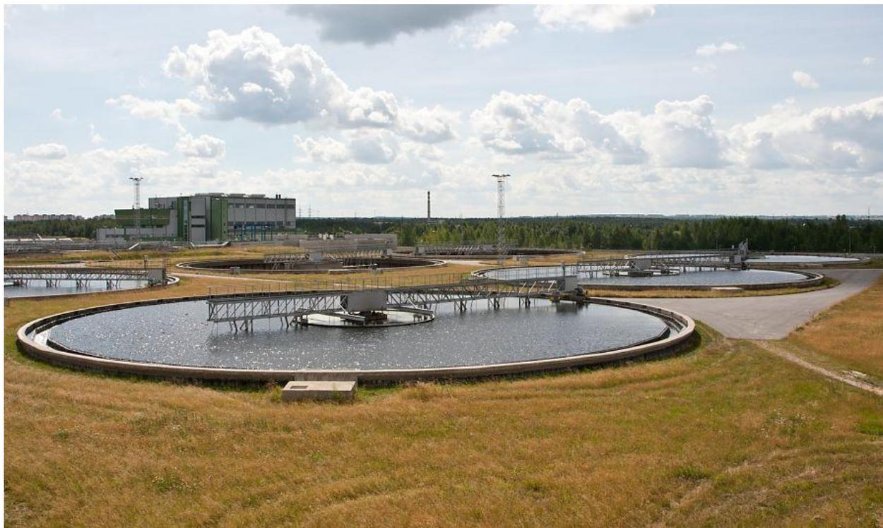
Рис. 2. Радиальные отстойники ГУП «Водоканал Санкт-Петербурга», Юго-Западные очистные сооружения
