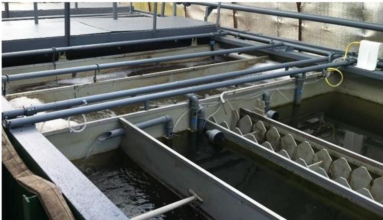
Рис. 2. Водоотстойники электромеханической службы метрополитена
